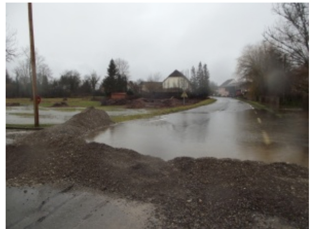
RD12A obstruée et inondée à Menoncourt.
